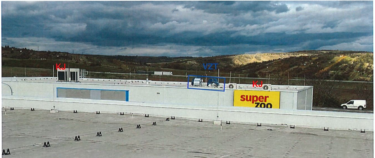
Obr. 4.9: Fotodokumentace zdroje hluku na střeše prodejny
