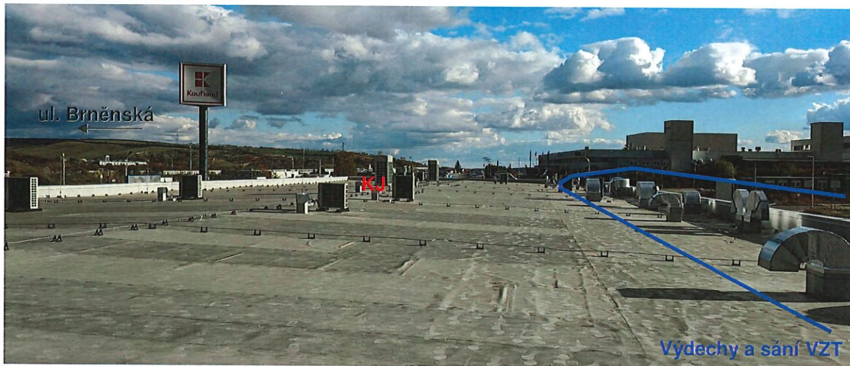
Obr. 4.7: Fotodokumentace zdroje hluku na střeše retailu
