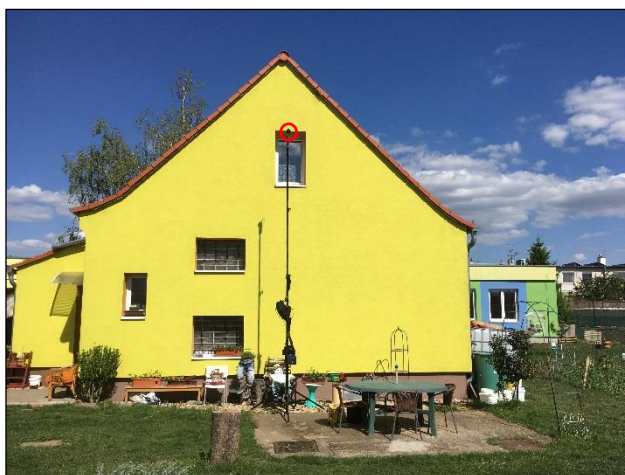
Obr. 14: Pohled od železnice
