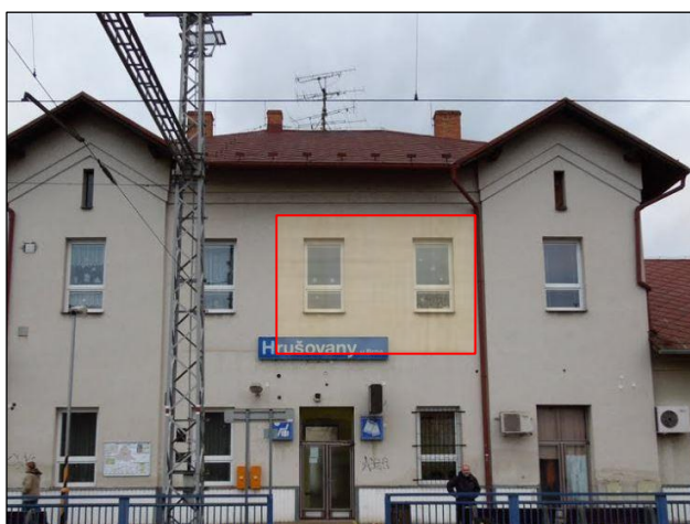
Obr. 9: Pohled od železnice
