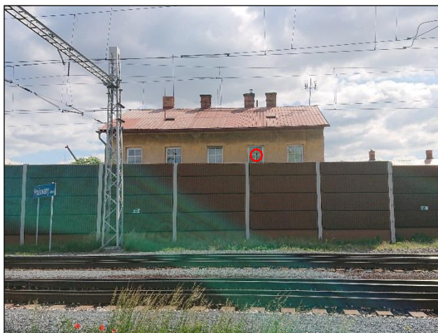
Obr. 3: Pohled od železnice
