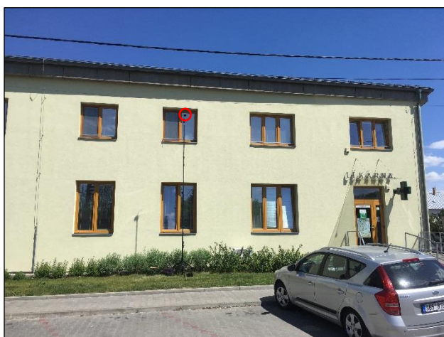
Obr. 6: Pohled od železnice
