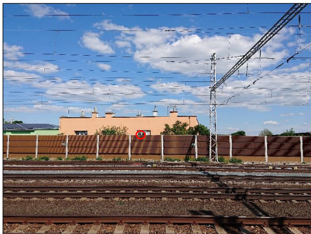
Obr. 12: Pohled od železnice
