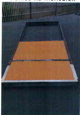
Pohled na monoblok
