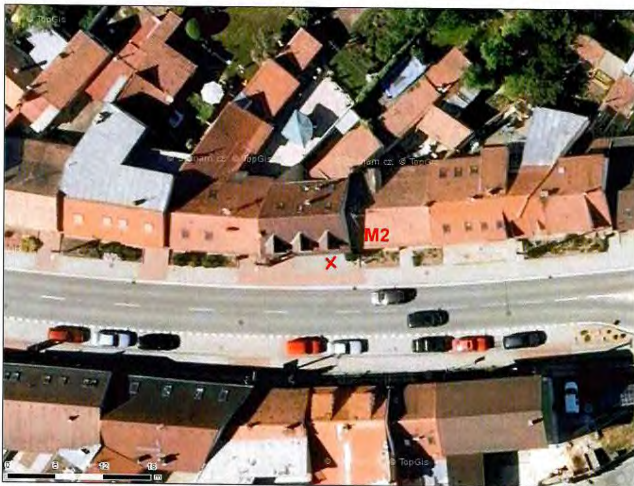
Obr. 7 Letecký pohled na M2
